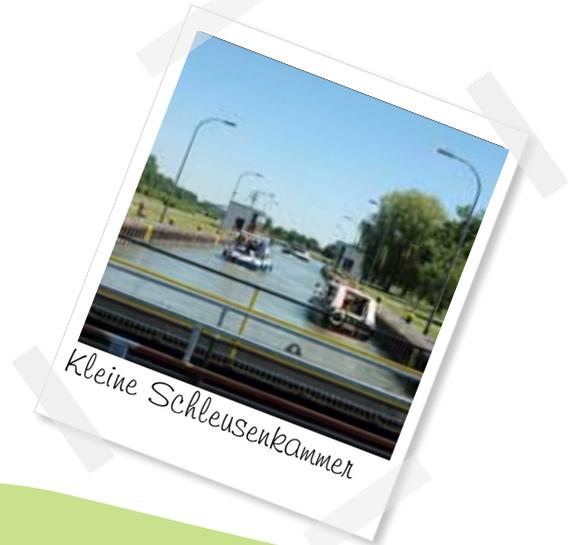
1923. Zwischen 1965 und 1967 wurde die Kleine Schleuse gebaut, die auch für Großmotorgüterschiffe noch ausreichend Platz bietet. Die Bedienung der beiden Schleusen erfolgt von einem Zentralsteuerstand auf der Schleuseninsel. Die Pumpen im angeschlossenen Pumpwerk werden über eine Zentrale in Datteln ferngesteuert. Drei Pumpen sind dazu in der Lage, jeweils 3.800 Liter pro Sekunde aus dem Unter- in das Oberwasser zu befördern. Eine vierte Pumpe besitzt eine Kapazität von 5.000 Litern pro Sekunde.
